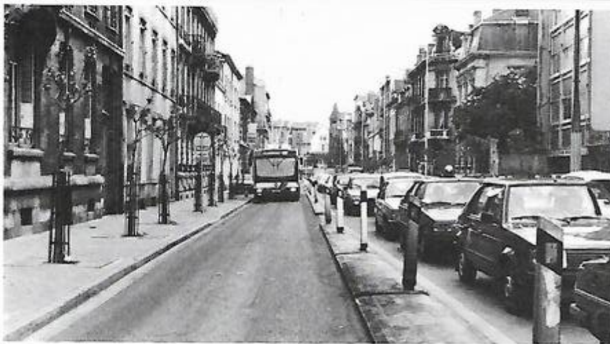
Implantation d'un couloir réservé au droit d'une zone de rétention de V.P. en heures de pointe. Les couloirs sont délimités par une bordurette signalée par des délimitateurs verticaux.
