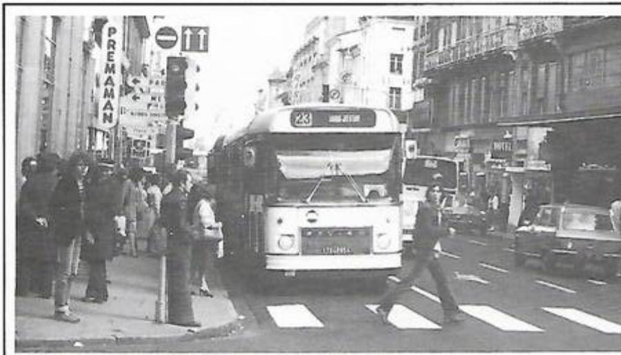
La rue Saint-Jean avant les travaux de l'Opération Trolleybus.
